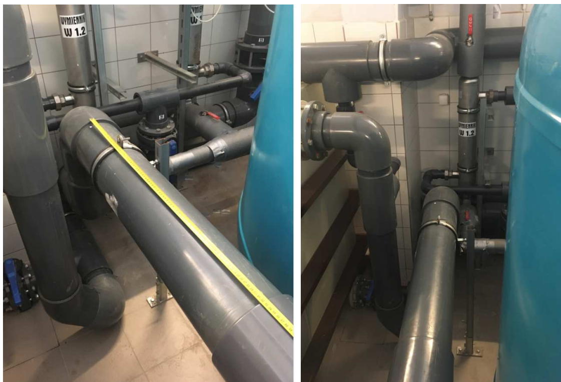
Fotografia: Odcinek rury PVC D=200mm w którym należy wykonać włączenie obiegu pompy ciepła.
